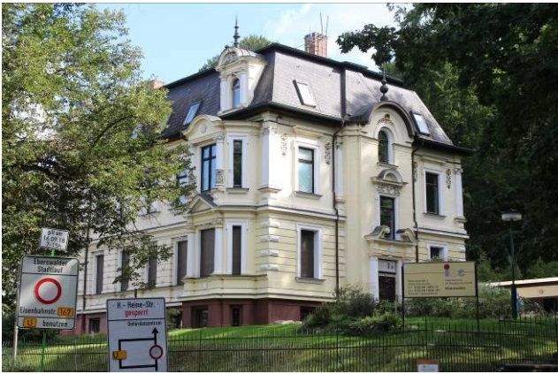
Ingenieurbüro für Bauplanung, Brunnenstraße 2
